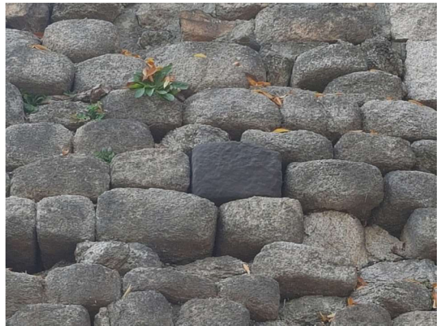
그림 12. 공주대에서 진행한 한양도성 성돌 복원(샌드 3D 프린팅 출력물)
